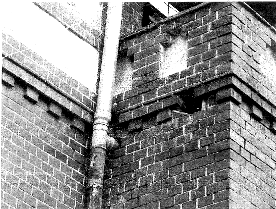
Fot.8. Ubytki w zbliżeniu, widoczny jest materiał gniazdowy wróbla lub kawki w większym otworze (aut. Szymon Wójcik).
